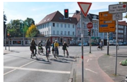
ARAS mit Zufahrt vom Radweg; Hinweiszeichen für Kfz „Bei Rot hier halten“ (Münster)
