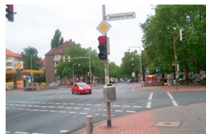
Signaltechnische Sicherung der Linksabbieger wegen zweistreifigem Kfz-Verkehr geradeaus und starkem Radverkehr auf Radweg (Hannover)
