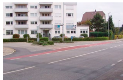
Breiter Einmündungstrichter mit zügiger Ein- und Abbiegemöglichkeit vorher (Friedrichshafen)
