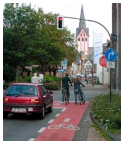
ARAS mit Zufahrt als Schutzstreifen (Kempen)
