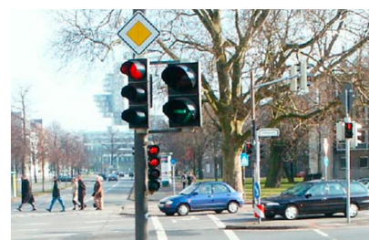
Zeitlicher Vorlauf für Kfz-Rechtsabbieger und Vorlaufgrün für Radverkehr bei gemeinsamer Phase (Hannover)
