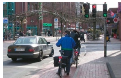
Beispiel Leer: Der Kfz-Verkehr darf nur rechts abbiegen, der Hauptstrom Radverkehr kann konfliktfrei geradeaus in Fußgängerbereich mit zugelassenem Radverkehr fahren.
