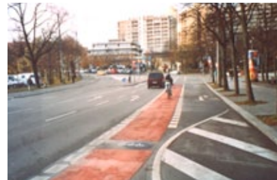
Übergang einer Radverkehrsführung aus dem Seitenraum baulich geschützt auf die Fahrbahn (Freiburg)
