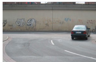
Radwegüberfahrten mit Verwendung von Rampenformsteinen (Bremen) Hinweis: erforderliche Furtmarkierung fehlt
