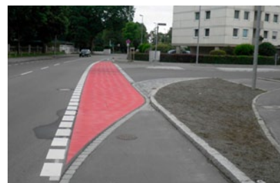
Einmündung nach deutlicher Verkleinerung des Einmündungstrichters und der Eckausrundung (Friedrichshafen)
