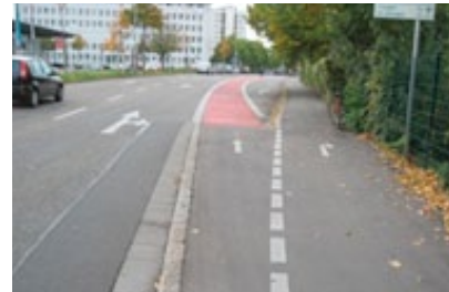
Übergang einer Radverkehrsführung aus dem Seitenraum baulich geschützt auf die Fahrbahn (Freiburg)
